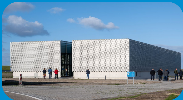
Siemens Trafogebouw - Breezanddijk
