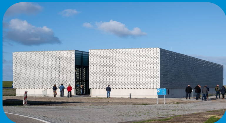
Siemens Trafogebouw - Breezanddijk
