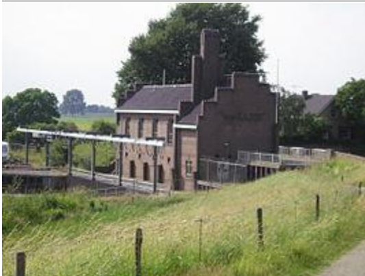
Gemaal van Sasse
